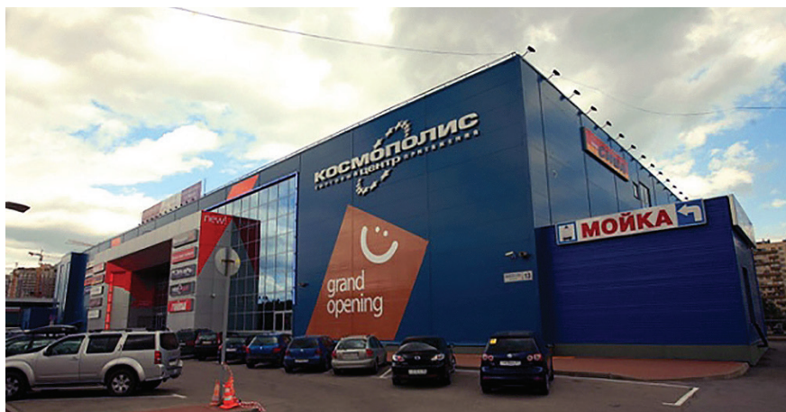
Торговый центр «Космополис» Общая площадь 20 700 кв. м Противопожарные и механические системы
