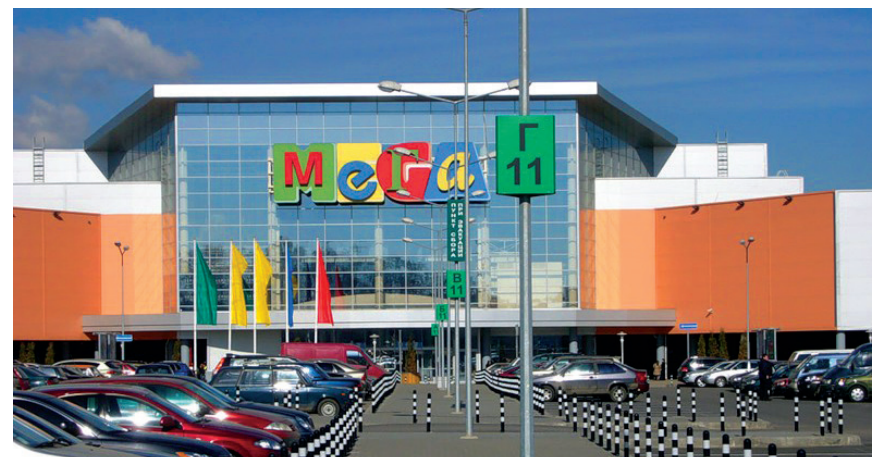
Торговый комплекс «МЕГА-Дыбенко» Общая площадь 182 000 кв. м Проектирование систем автоматической пожарной сигнализации, оповещения о пожаре и управления эвакуацией, охранной сигнализации, СКУД
