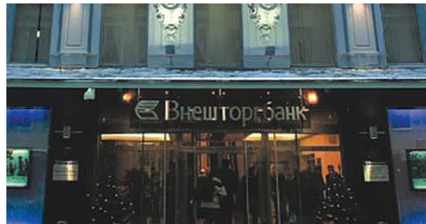
Офис банка ВТБ Проектирование противопожарных и слаботочных систем и их автоматизации
