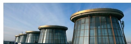
Пулково I. Реконструкция
