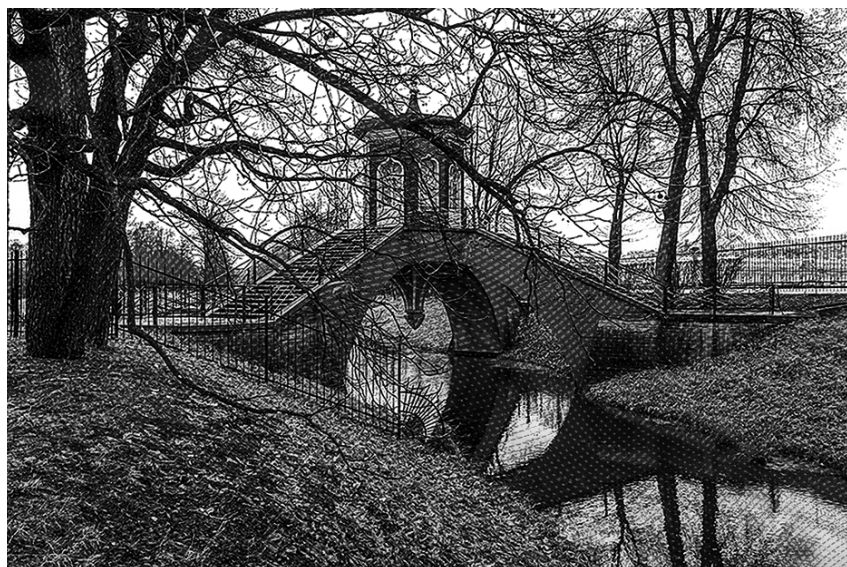
Часть Виттоловского водопровода
