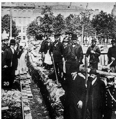
Прокладка телефонного кабеля
