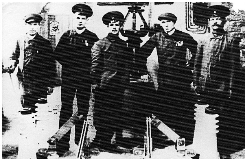
Монтажники электрооборудования на Охтинском заводе
