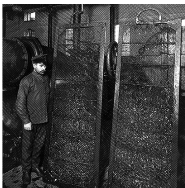
Очистка фильтраозонной установки
