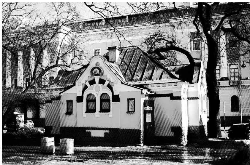
Общественный туалет, построенный по проекту А. Зазерского
