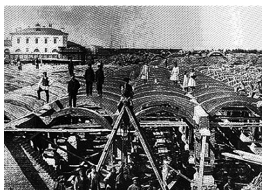
Строительство фильтраоозонной установки
